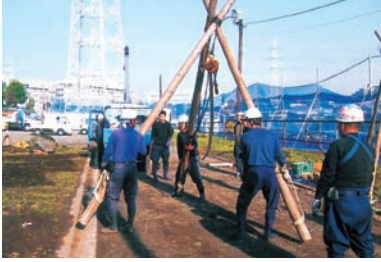
三又を安全且つ素早く移動するための作業。レッカー使用には無い呼吸合わせを学ぶ
