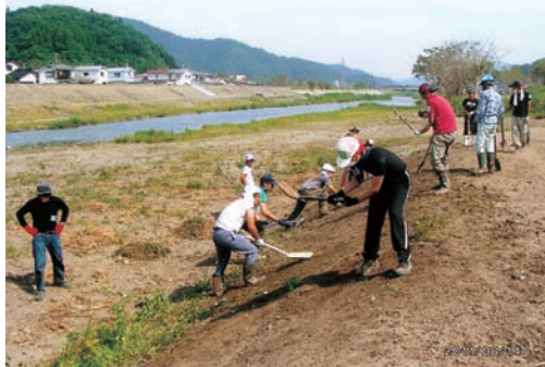
大槌川の河川敷。津浪は土手を越え住宅を襲つた。ガレキを撤去した後、菜の花畑にする整地作業
