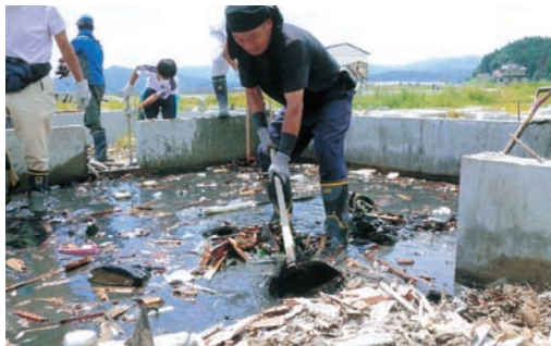
ドロドロとした汚水の中に残されたガレキの撤去作業。悪臭がなければ造作のない仕事なのだが
