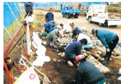
木曽石、真黒石、新鞍馬の異なる石材を小づめに用いた延段の講習風景
